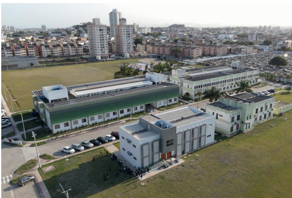
Figura 1: Vista aérea do campus Vila Velha
