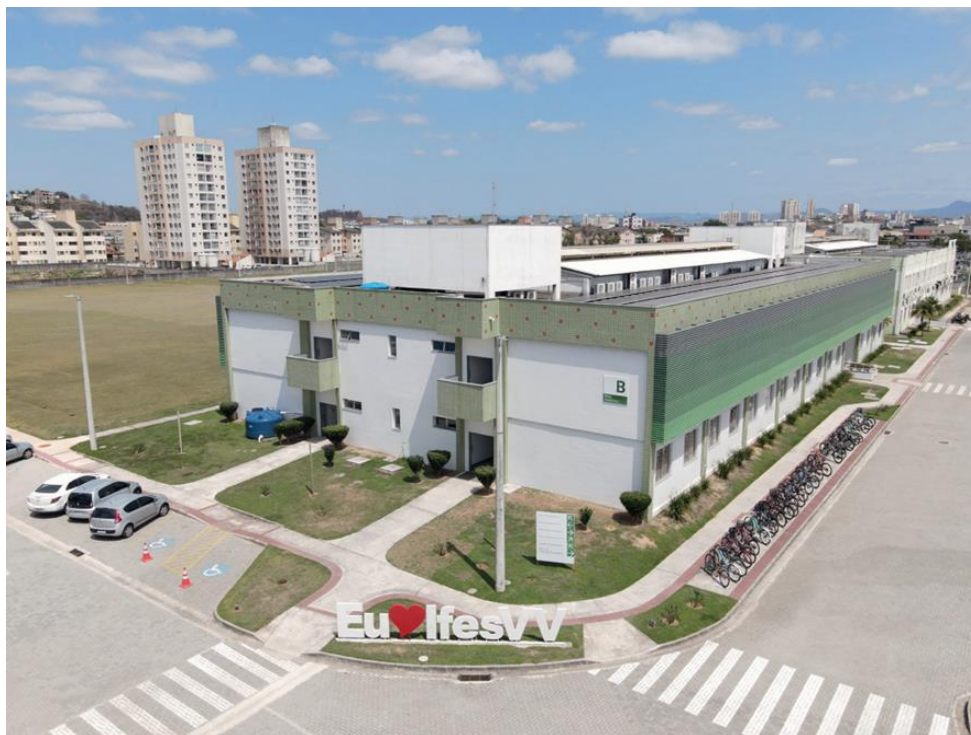
Figura 2 - Vista aérea do campus Vila Velha
